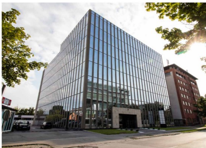
▲ Poslovni center Y Ljubljana v upravljanju BTC PROP
